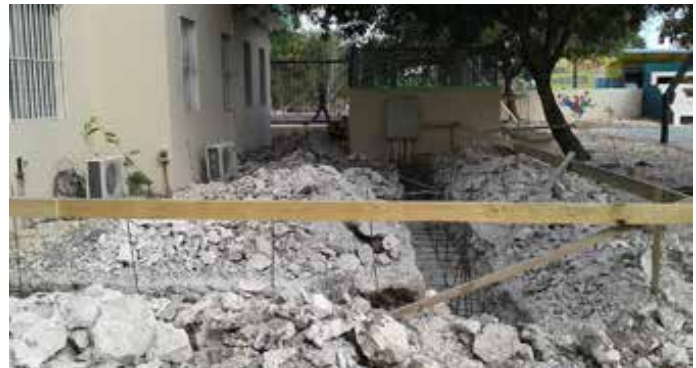
Inicio de la construcción de la Oficina de Intermediación Laboral y Pasantías (OILP)
